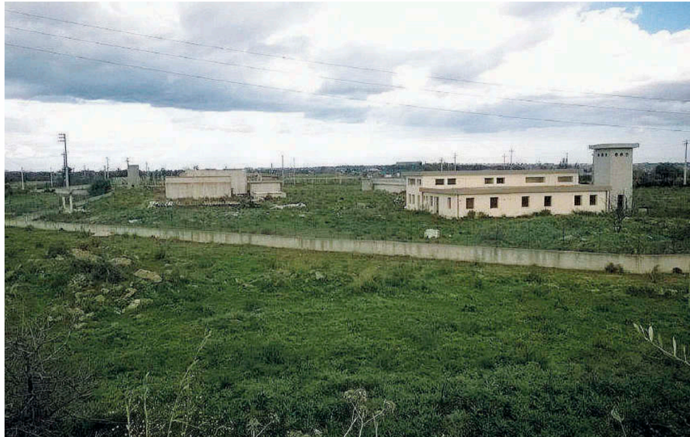
L'impianto di depurazione ad Augusta. La città è tra quelle segnalate dall'Ue, un agglomerato industriale con un depuratore che non funziona
